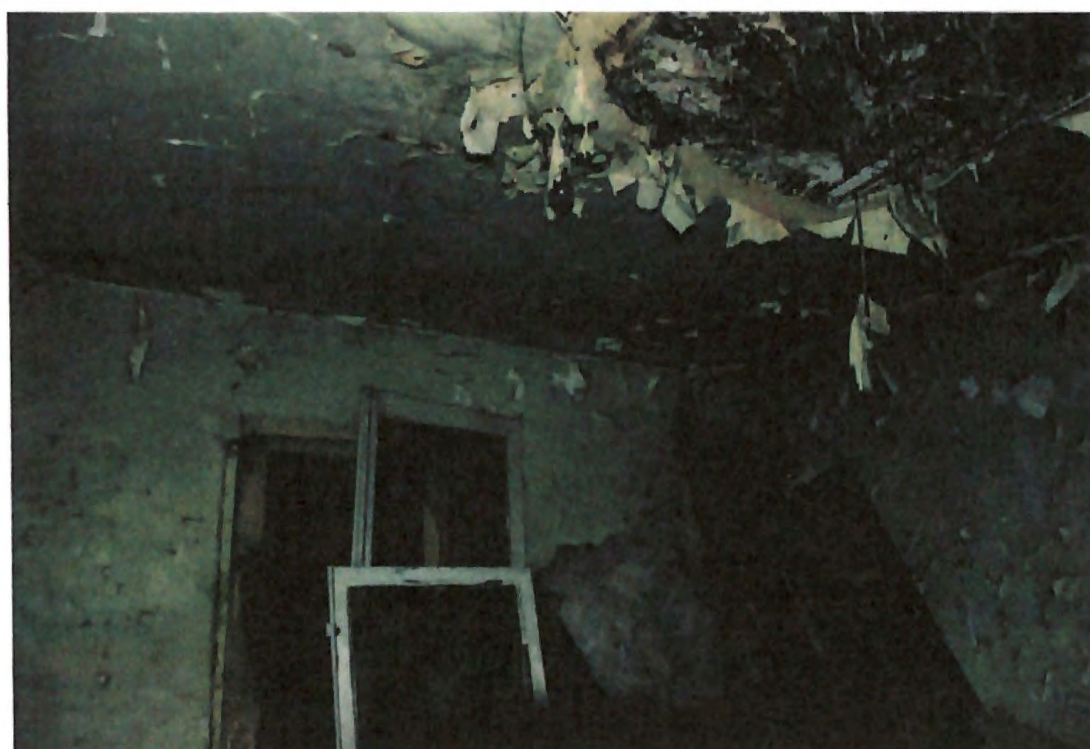
Fig. 18. Infiltrații de apă la nivelul planșeului din lemn Sursa: arhiva SC CEC SOLUTIONS SRL
