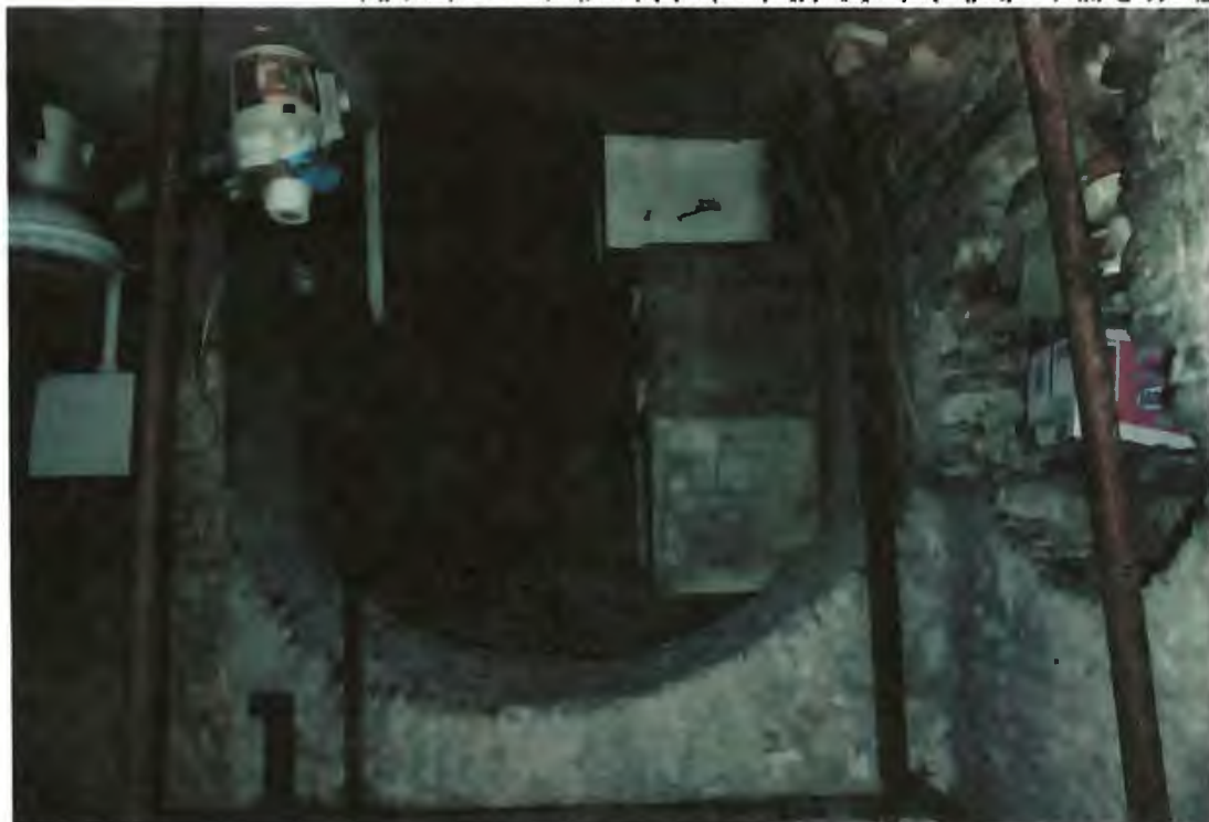
Fig. 11. Bolțile longitudinale de cărămidă ale subsolului susținute cu popi metalici Sursa: arhiva SC CEC SOLUTIONS SRL
