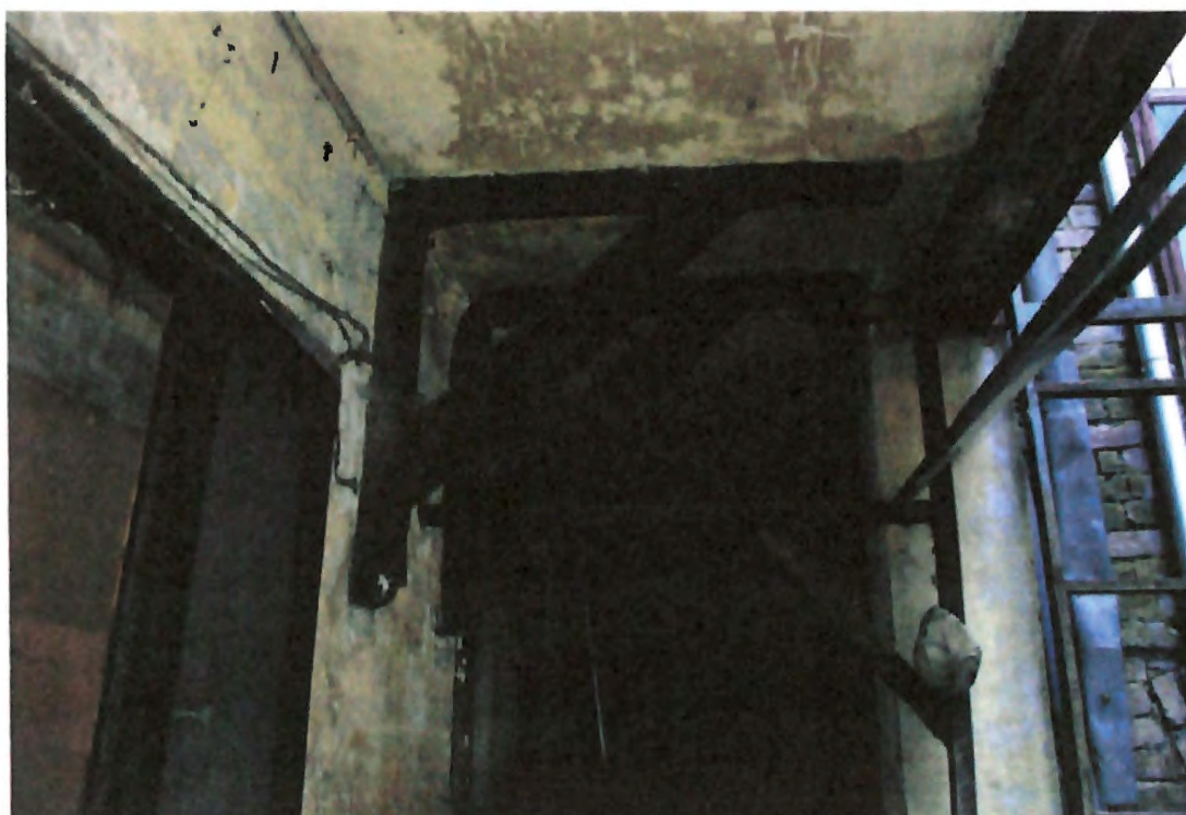
Fig. 15. Corp B – susținerea consolei etajului de la corpul A cu elemente metalice Sursa: arhiva SC CEC SOLUTIONS SRL
