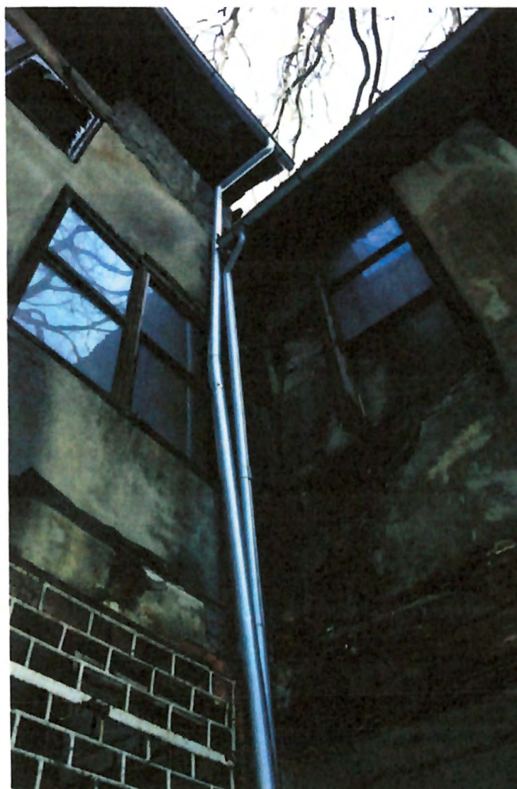
Fig. 13. Îmbinare corp A și corp B în curtea interioară; jgheaburi și burlane montate defectuos care favorizează scurgerea apelor pe fațade și deteriorarea acestora Sursa: arhiva SC CEC SOLUTIONS SRL
