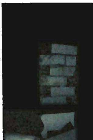
Fig. 20. Goluri (de uși și ferestre) închise cu zidărie BCA într-o etapă ulterioară din exploatarea clădirii Sursa: arhiva SC CEC SOLUTIONS SRL
