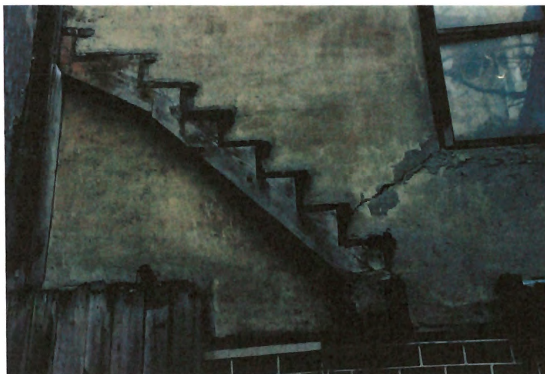
Fig. 16. Corp A – scara din lemn de acces la etaj montată defectuos Sursa: arhiva SC CEC SOLUTIONS SRL
