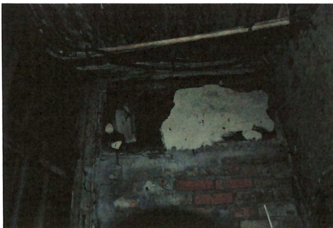
Fig. 17. Infiltrații de apă la nivelul planșeului din lemn Sursa: arhiva SC CEC SOLUTIONS SRL
